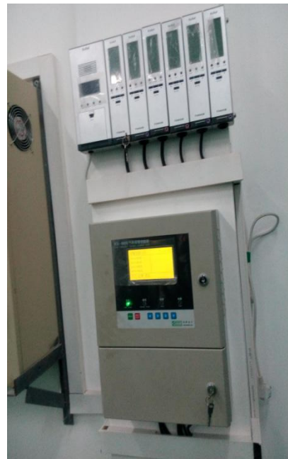
可燃气体报警控制器及探测器
