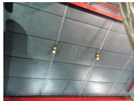
可燃气体报警控制器及探测器
